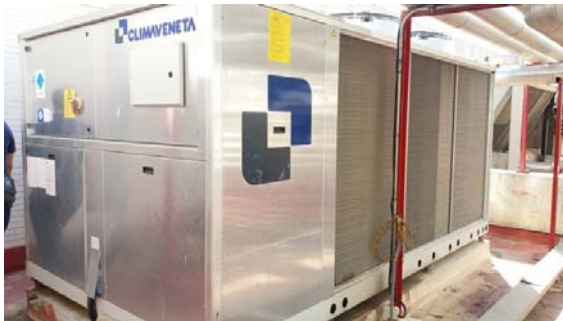
ENFRIADORA A MANTENER (BOMBA DE CALOR)
